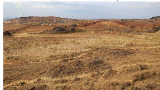
**Figura 3-25:** Processos erosivos incipientes do tipo laminar em área de aterro, nas imediações da antiga área da MMX (leste da ADA). Coordenadas: 576414.00 m E; e 7776664.00 m N. Ponto 4.
