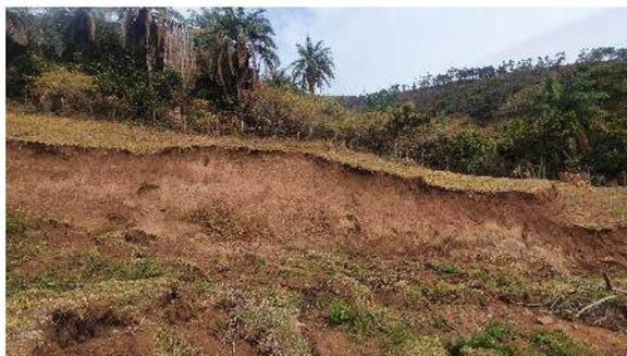
**Figura 1-77** - Superfície de ruptura de um movimento de massa do tipo escorregamento, em área a oeste da PDE, no Ponto 2 (coordenadas 572705.63 m E; e 7776398.45 m N).
