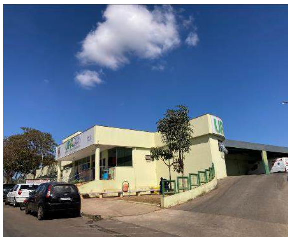
Figura 3-16 – Unidade de Pronto Atendimento em Igarapé. Fonte: Ferreira Rocha, pesquisa de campo – 2022
